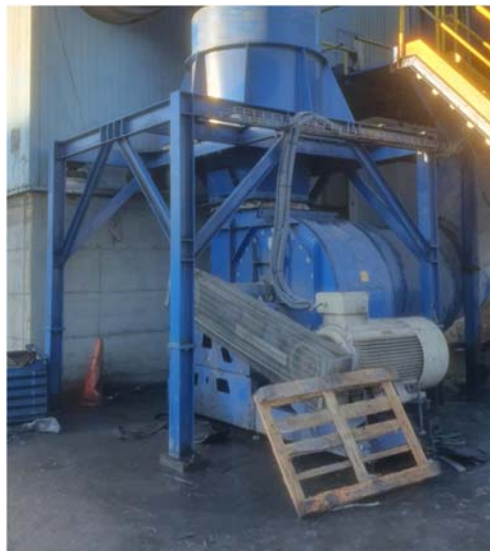
Figura 9. Foco 4: motor chimenea de depuración de humos.
