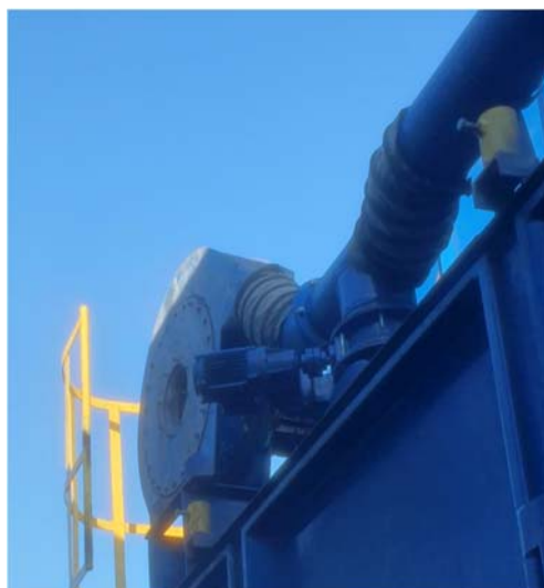
Figura 10. Foco 5: ventilador de caracol sobre filtro de mangas
